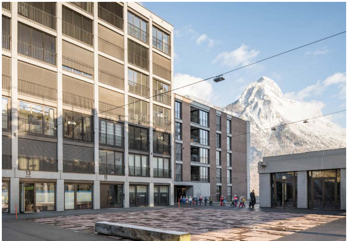
Der im Erdgeschoss der pktg-Liegenschaft «Im Stoffel» integrierte Kindergarten schafft Raum für Bildung und Begegnung mitten im Wohnumfeld. Quelle: Cristuzzi Immobilien-Treuhand AG
