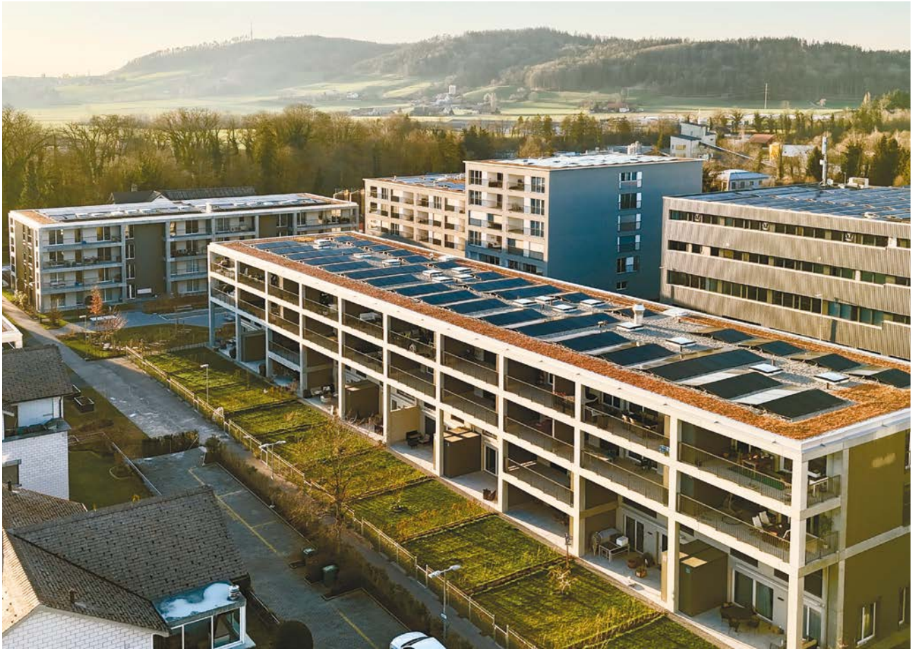
Bild: Überbauung Aadorf, Weiernstrasse, nach MINERGIE zertifiziertes Gebäude, Bezug: Oktober 2024 Installierte Leistung der PV-Anlage: 178 kWp
