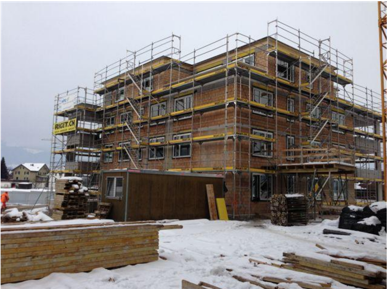
Der Winter hält Einzug auf der Baustelle Sonnengrund in Benken/SG.
