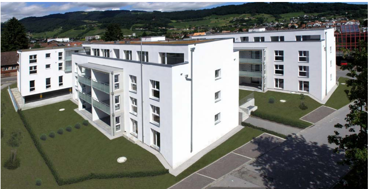
Überbauung „Zinggen“, Au/SG
